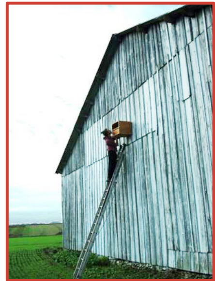
Installation d'un nichoir à Faucon crécerelle
