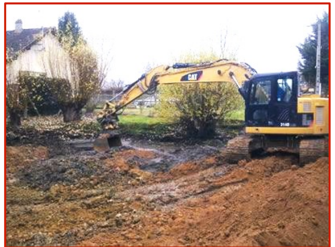
Curage avec pelleuse
