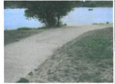
Fig. 3 - Vue d'ensemble vers l'aval.
