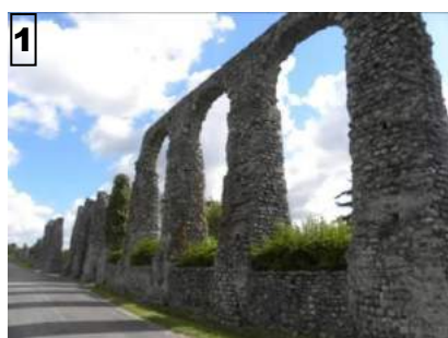
Aqueduc de Luynes
