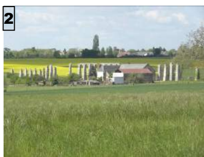
Depuis la Pie Noire, secteur de la prise d'eau de l'ancien aqueduc. Extensions résidentielles de Luynes en arrière-plan.
